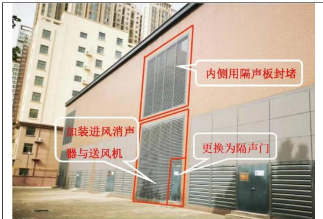
红旗220kV 变电站西面散热间降噪措施
